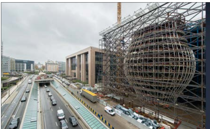
QUARTIER EUROPÉEN – Construction de la structure de l'amphore et de la façade extérieure.
