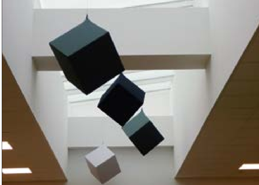
ACOUSTIQUE – Les call-centers ont été équipés de dalles et cubes acoustiques, pour éviter que les centres d'appels ne se transforment en immense cacophonie.
