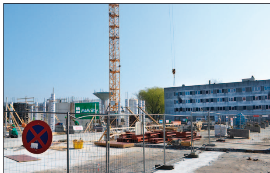
DÉMOLITION ET CONSTRUCTION NEUVE – Le bâtiment en arrière plan sera détruit alors qu'une nouvelle tour passive verra le jour au centre du site.
