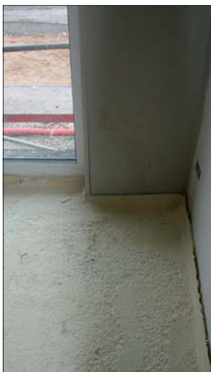
ISOLATION – La construction est réalisée sur radiers, sur lesquels ont été projetés 25 cm de chape polyuréthane.
