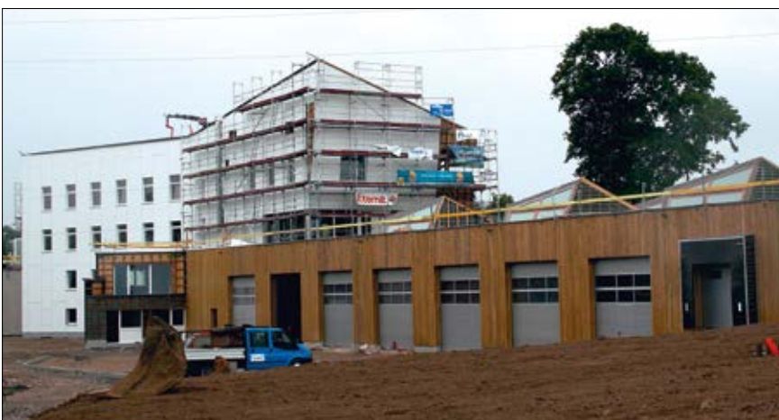
VUE ARRIÈRE – Les halls de stockage sont enterrés par rapport au bâtiment de bureaux.
