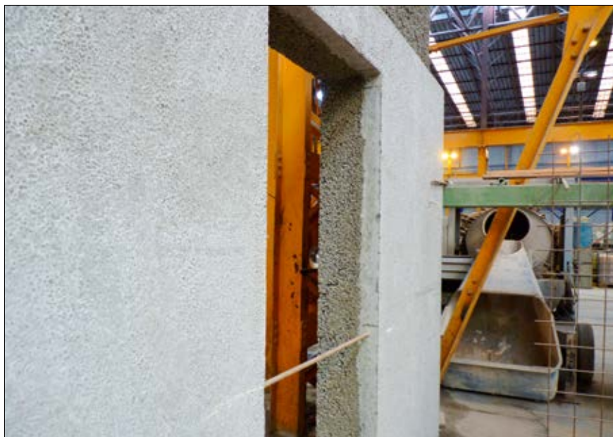
BÉTON DE BOIS – Plus léger que le béton normal, il présente des qualités en matière d'isolation thermique, acoustique et de résistance au feu sans négliger l'inertie thermique.
