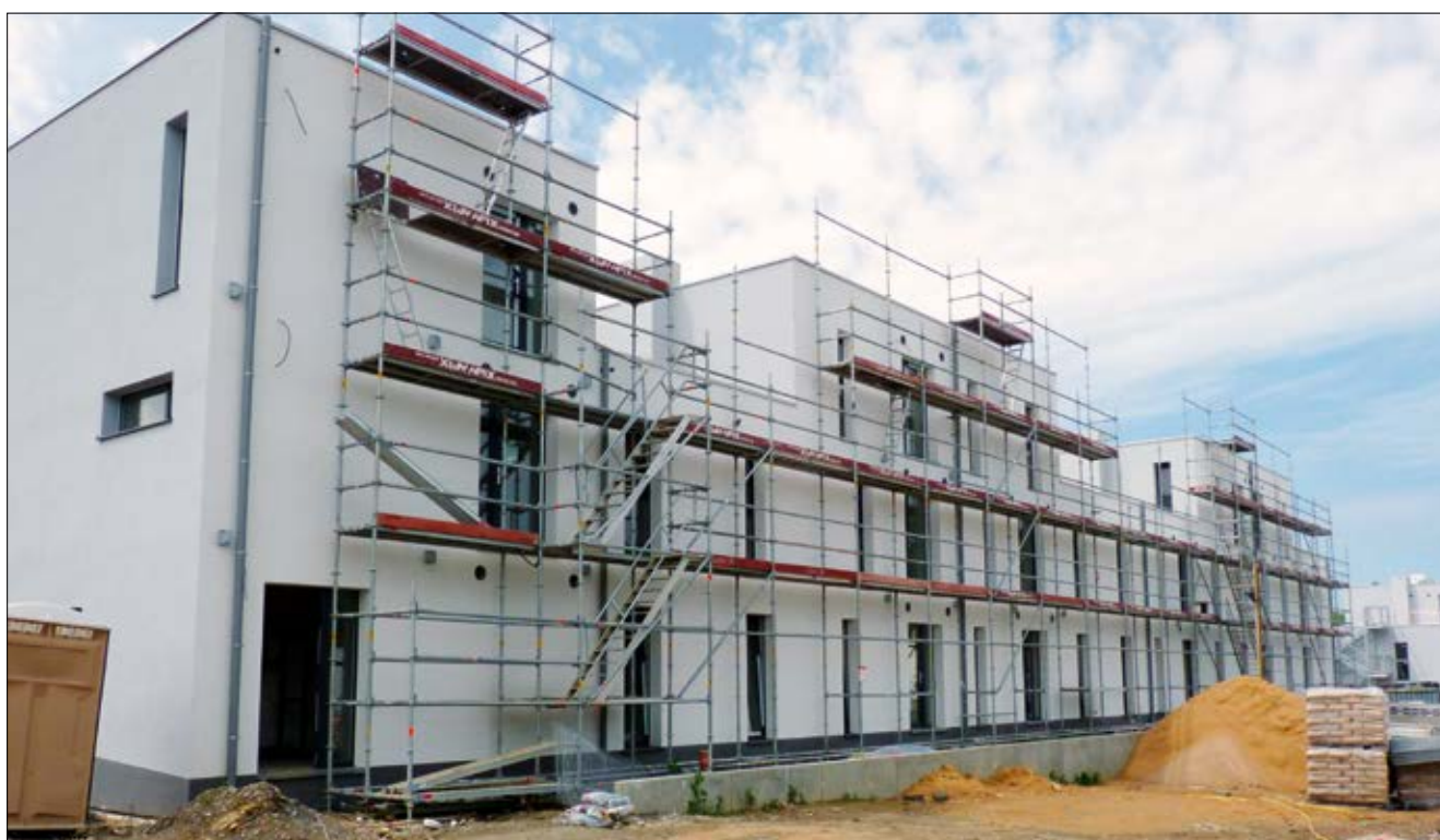
CONSTRUCTION MODULAIRE - Une seule équipe de quatre hommes peut effectuer le montage du gros œuvre d'une unité de 60 m 2 en une semaine.
