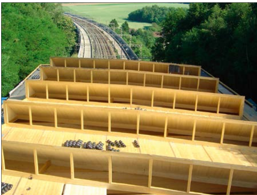
VUE SUR LES LANTERNEAUX – Le hall des sport est érigé sur une dalle béton surplombant les quatre voies de chemin de fer.
