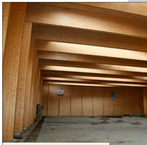
1.600 M 2 – La superficie du hall permet d'accueillir trois terrains dans la largeur.
