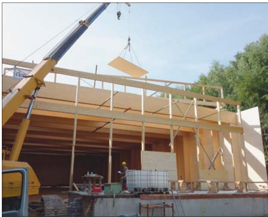
MONTAGE – La répartition régulière des charges a été la plus grande difficulté à surmonter.
