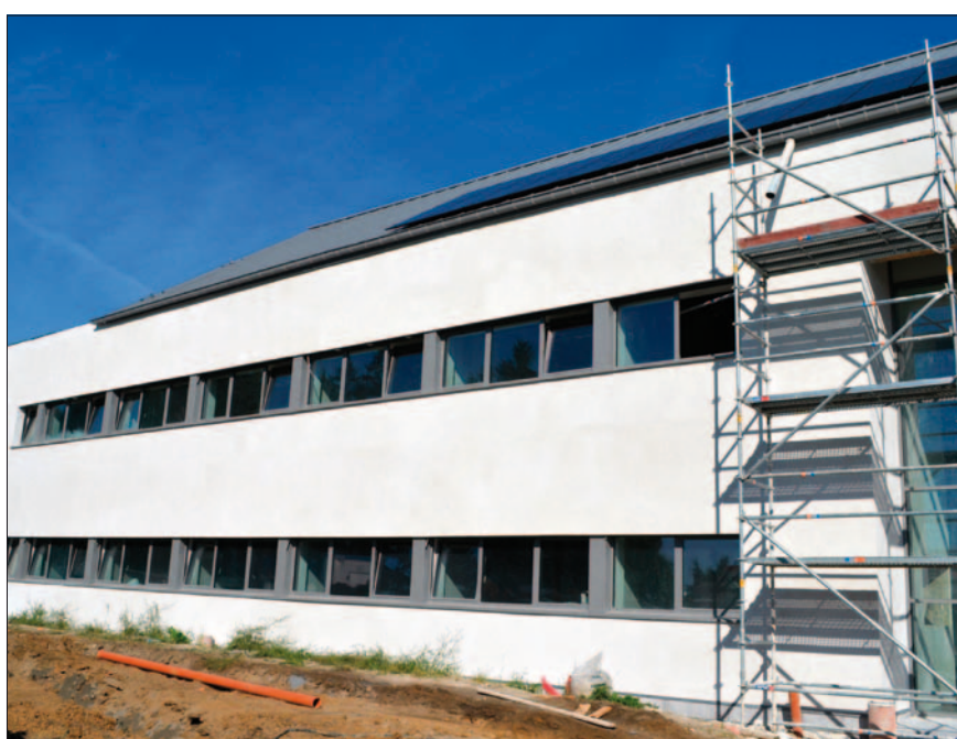
FAÇADE – La finition à la chaux colorée donne un résultat de fort belle facture.
