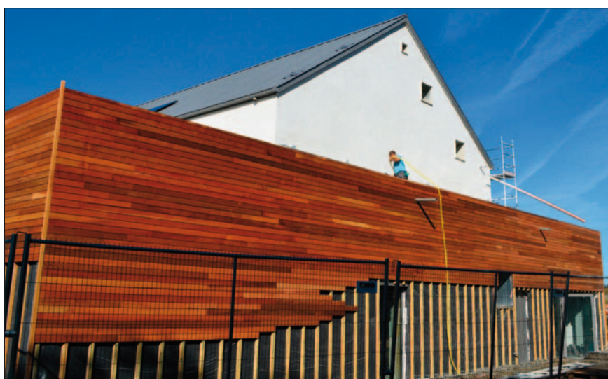
BARDAGE – Vue latérale du bâtiment avec son bardage en cèdre.
