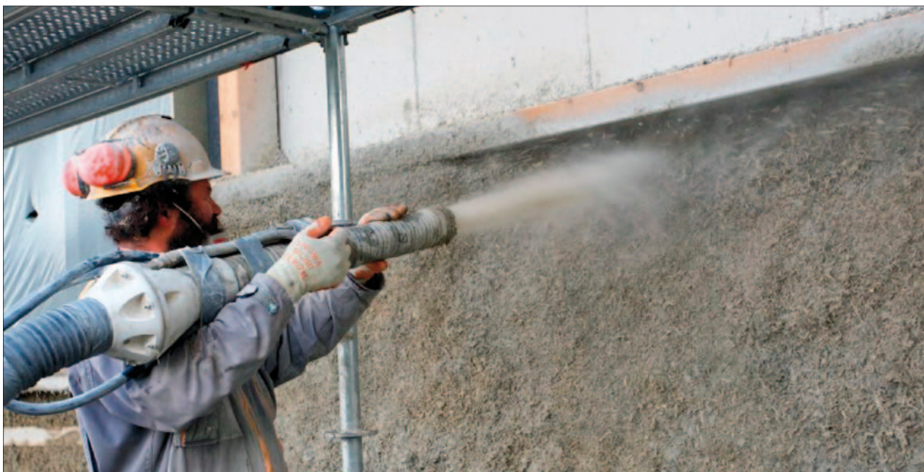
PROJECTION – 500 m 3 de béton mélangé à du chanvre et de la chaux ont été nécessaires pour isoler les murs.
