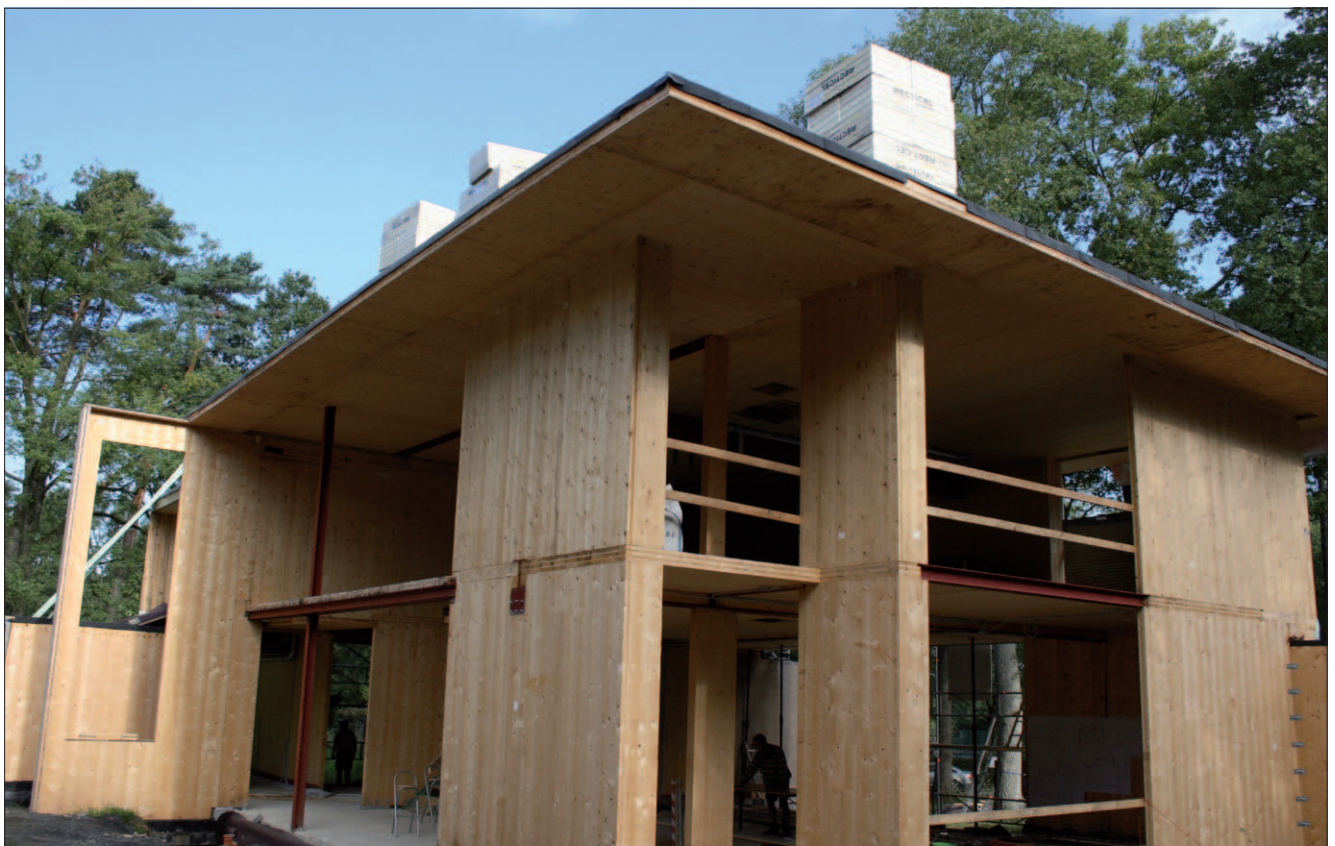
265 M 2 – La structure en bois de l'imposante villa a été réalisée en à peine deux semaines.
