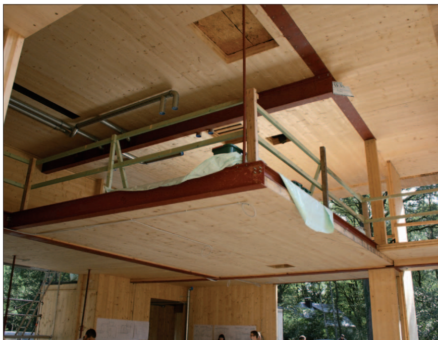
PORTE-À-FAUX – Des poutres métalliques ont été nécessaires pour consolider l'ensemble.
