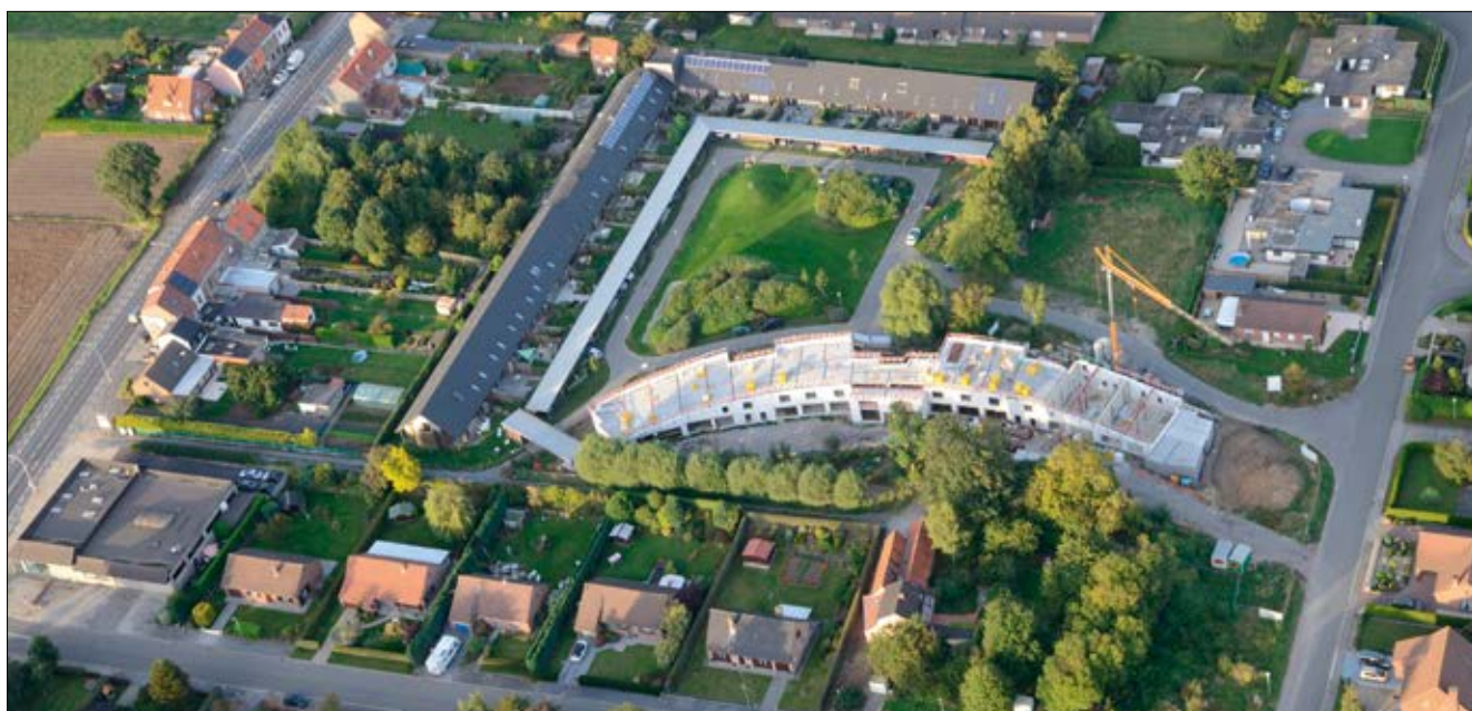
VUE AÉRIENNE – La forme courbée des futurs logements à énergie positive contraste avec les pavillons mitoyens de la première phase.
