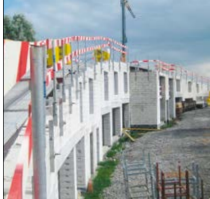
DEUXIÈME PHASE – Les murs se composent de blocs en béton cellulaire avec des hourdis en béton pour assurer une plus grande inertie aux logements.
