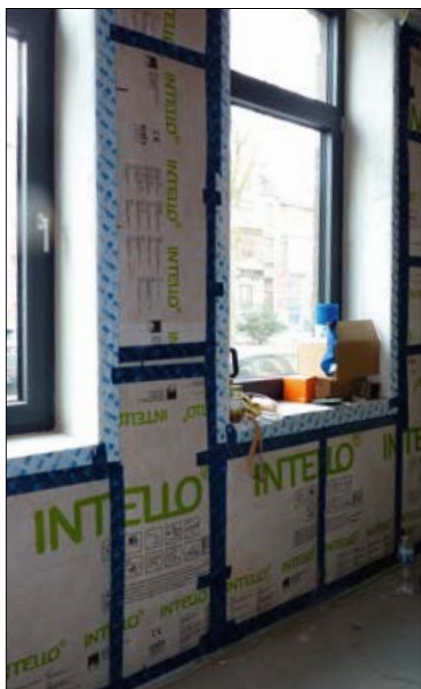
ISOLATION – La façade avant étant classée, il a fallu opter pour une isolation par l'intérieur des murs.
