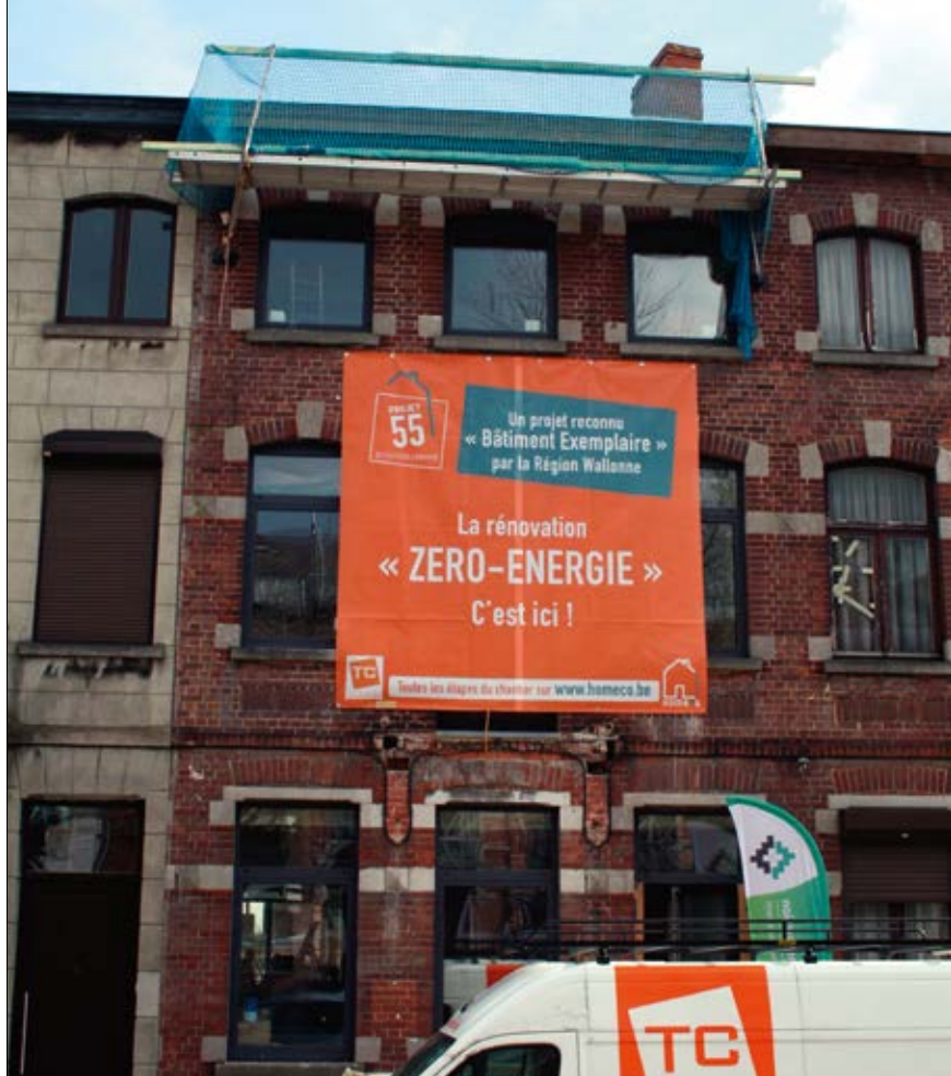
DÉFI – Atteindre le standard zéro énergie par la rénovation d'une ancienne habitation de rangée à Mons.
