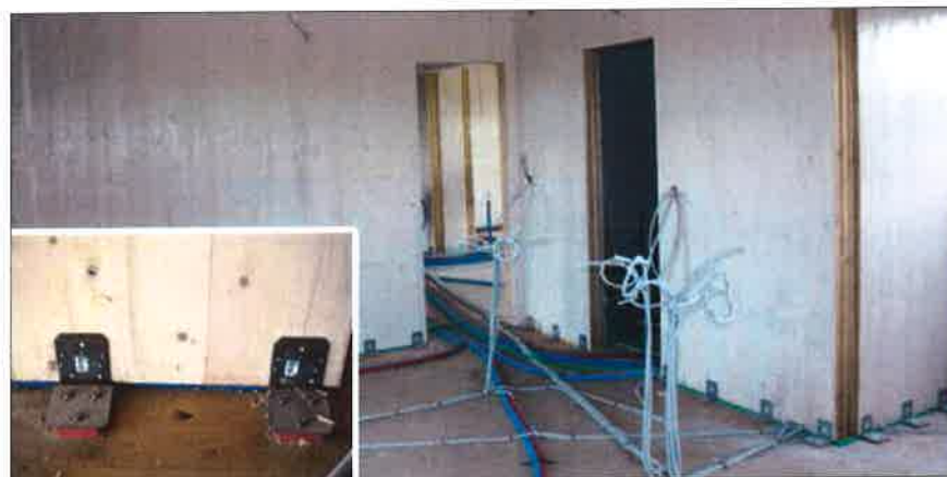
INTÉRIEUR – Pour améliorer l'acoustique, les planchers et les murs ont été désolidarisés.
