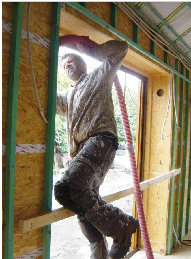
TRÈS BASSE ÉNERGIE – L'isolation renforcée permet à l'habitation d'atteindre un K 15.
