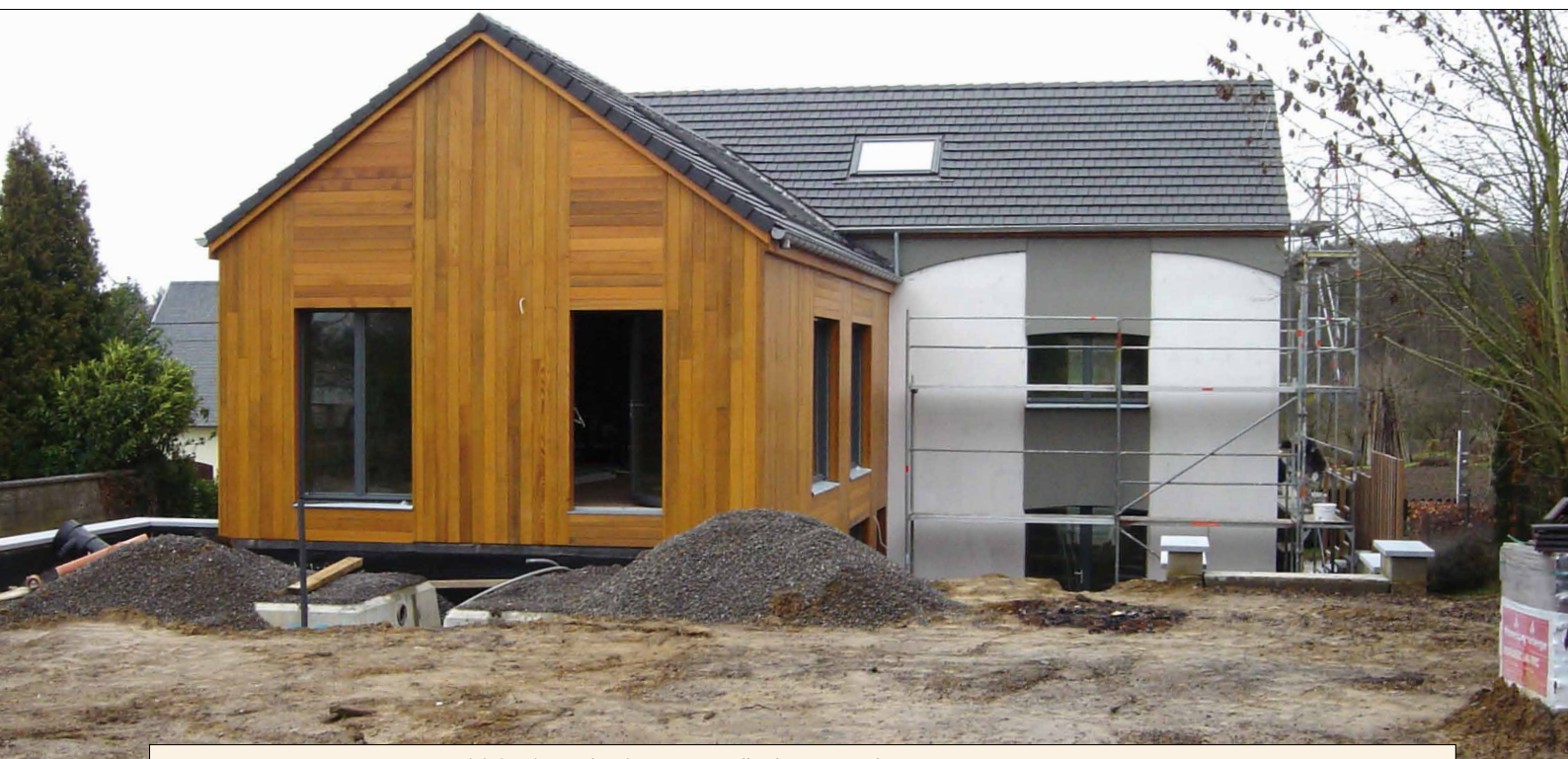
ANCIENNE FERMETTE - L'ancienne partie a été rénovée et prolongée par une nouvelle aile en ossature bois.
