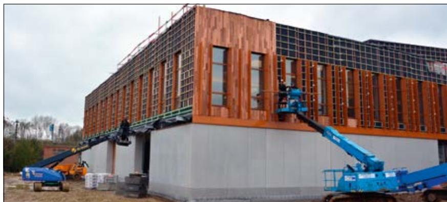
**BOIS** – Pour l'ossature bois, des panneaux de bois massif de 8 cm d'épaisseur ont été utilisés, sur lesquels ont été posés l'isolation avec des pièces perpendiculaires en «peigne» capables d'accueillir les lattes et contre-lattes et les lames pare-soleil.
