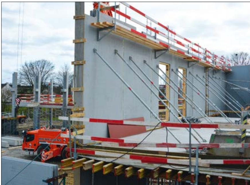
**MURS ET STRUCTURES** – Le tout est en béton. Mais la particularité des murs réside dans le fait que ce sont des éléments composites. Ils sont composés d'un voile intérieur, d'une isolation et d'un voile extérieur. Ils ont été construits en une seule pièce et en usine.
