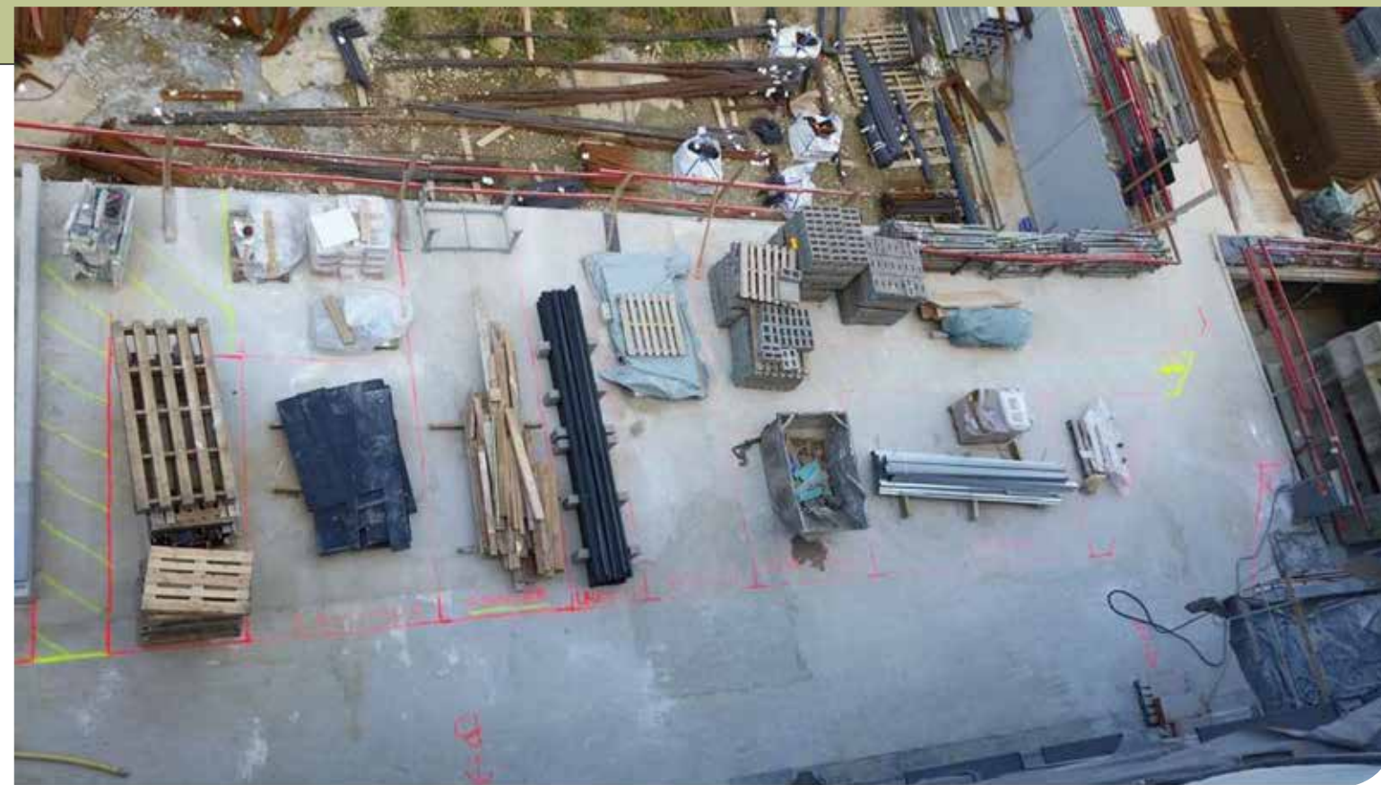
Un chantier bien conçu, où chaque chose est à sa place... c'est aussi ça le lean management .
